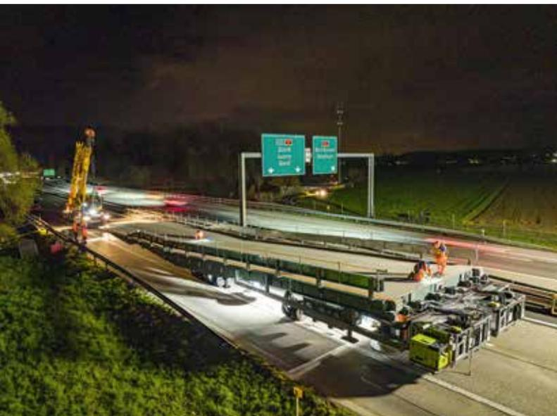
Im ersten Schritt werden die Auffahrampen montiert.
