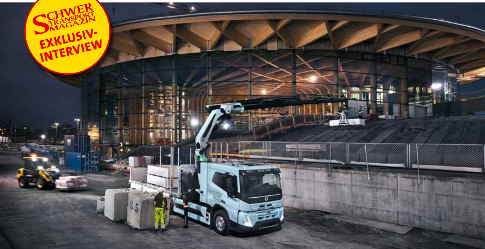
Ein elektrisch betriebener Volvo FMX beliefert eine Baustelle mit Material.
