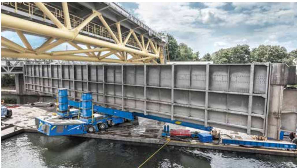
Präzisionsarbeit auf einem schwimmenden Ponton. Bei engsten Platzverhältnissen helfen SCHEUERLE SPMT bei der Demontage eines alten Hochwassersperrtors.
