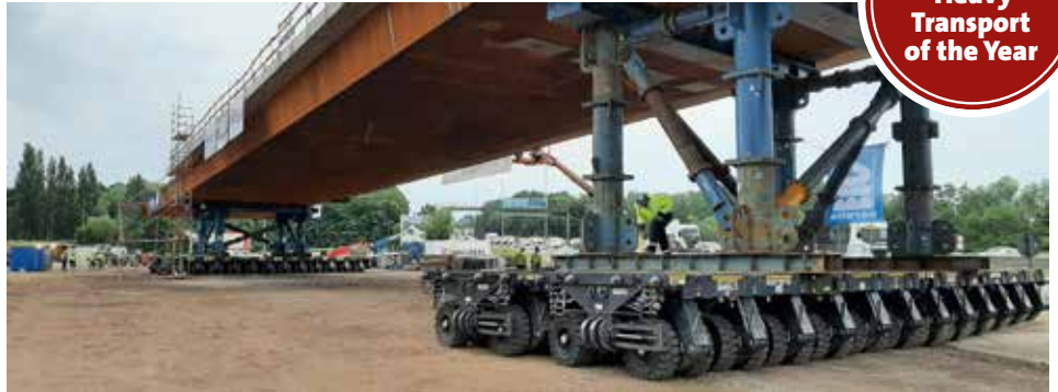
Die 105 m lange, 17 m breite und 1.000 t schwere Brücke liegt auf den Hubsystemen, die auf den beiden 24 Achslinien Cometto MSPE montiert sind.
