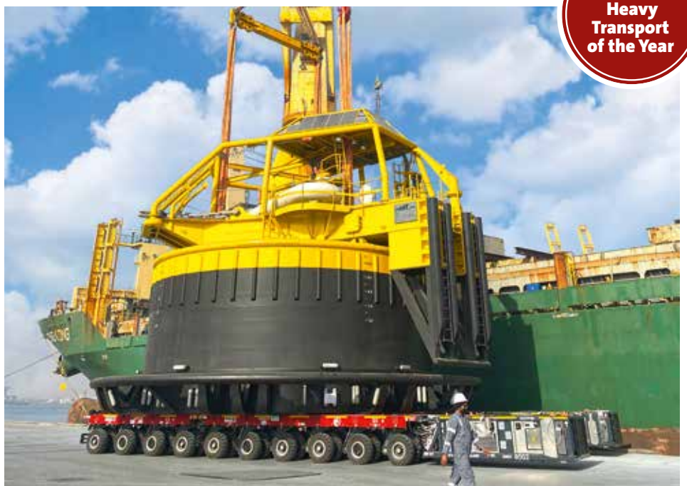
Bis zu 336,6 Tonnen lasten auf den SPMTs.
