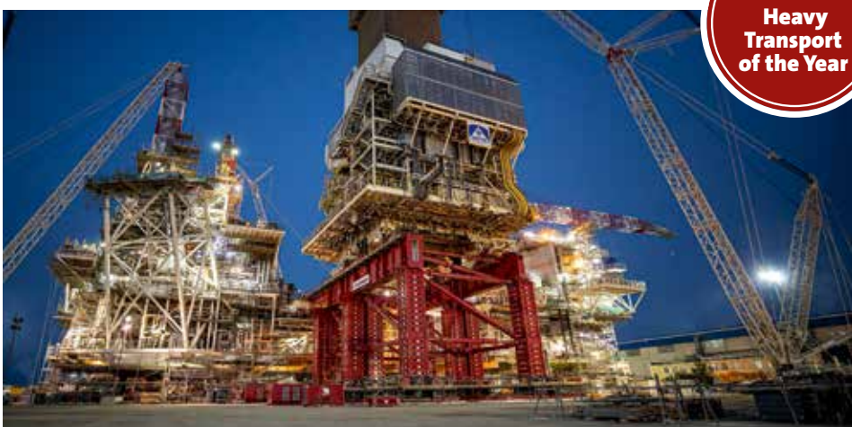
Insgesamt 120 Achslinien von SPMT transportierten die Module bis zur Plattform.
