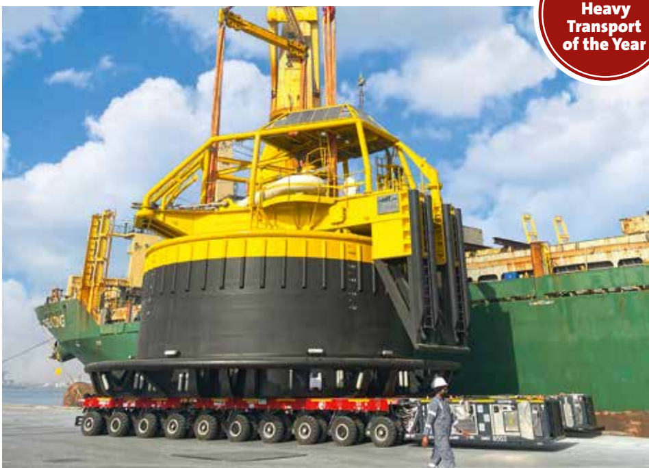
Bis zu 336,6 Tonnen lasten auf den SPMTs.
