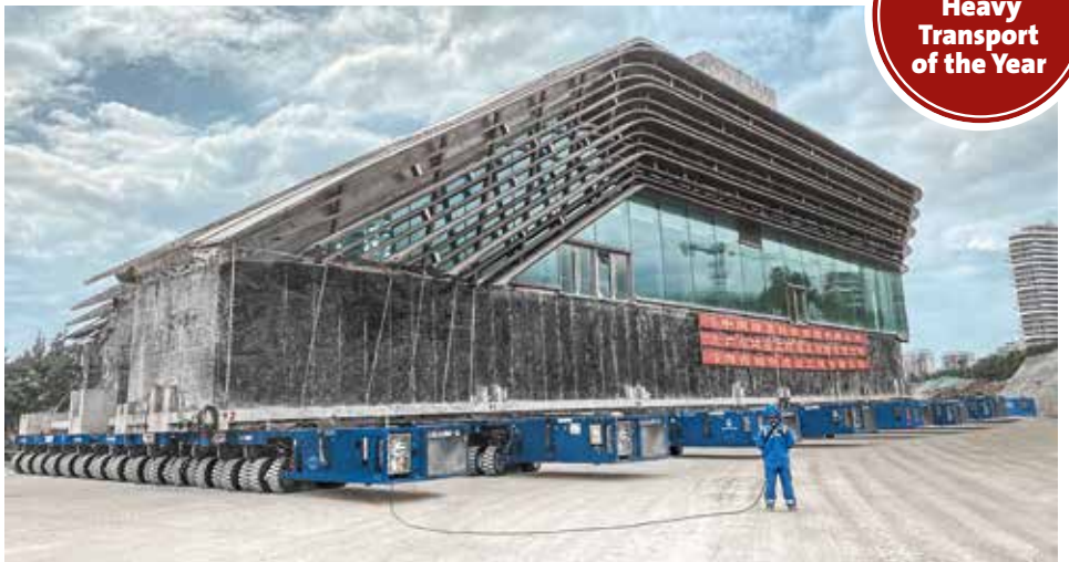
Das 7.500 Tonnen schwere Hotel ist auf 254 Achslinien SCHEUERLE SPMT platziert.
