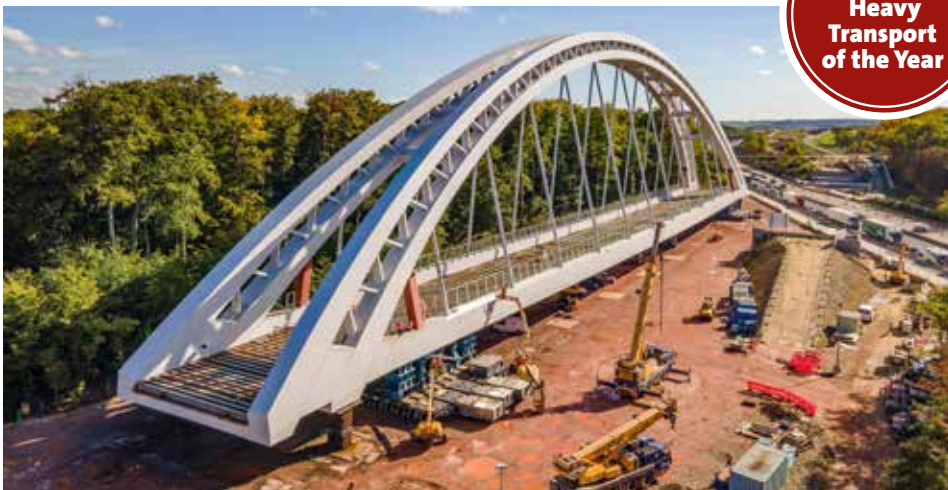
Die insgesamt 180 Achslinien der Cometto-SPMTs sind unter Brücke platziert.
