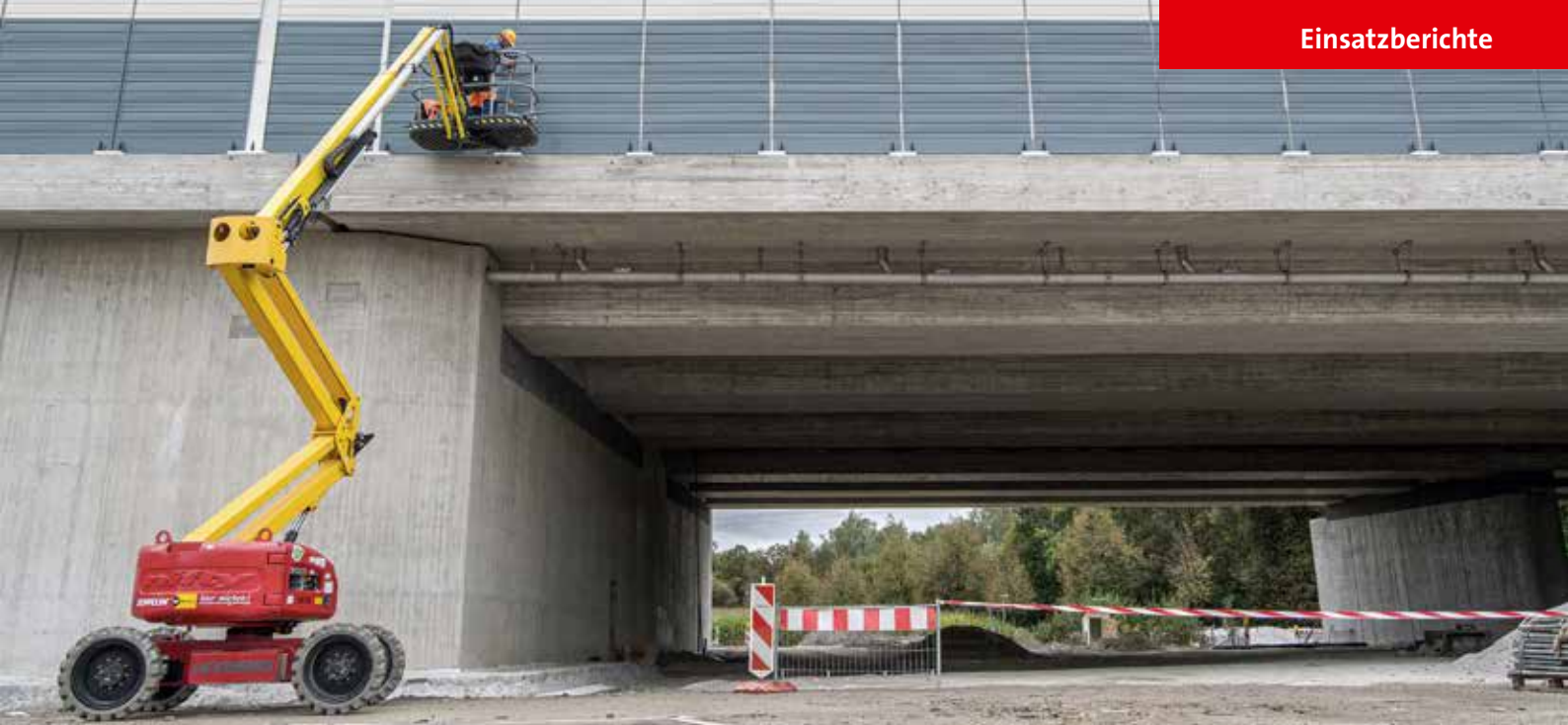
Für Arbeiten von der Unterführung aus musste der Teleskop-Arm der Arbeitsbühne beinahe auf seine gesamte Länge ausgefahren werden.
