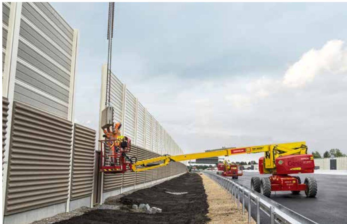
In die Horizontale: Gelenk-Teleskopbühnen von Zeppelin Rental bieten eine hohe seitliche Reichweite ohne Abstützung.
