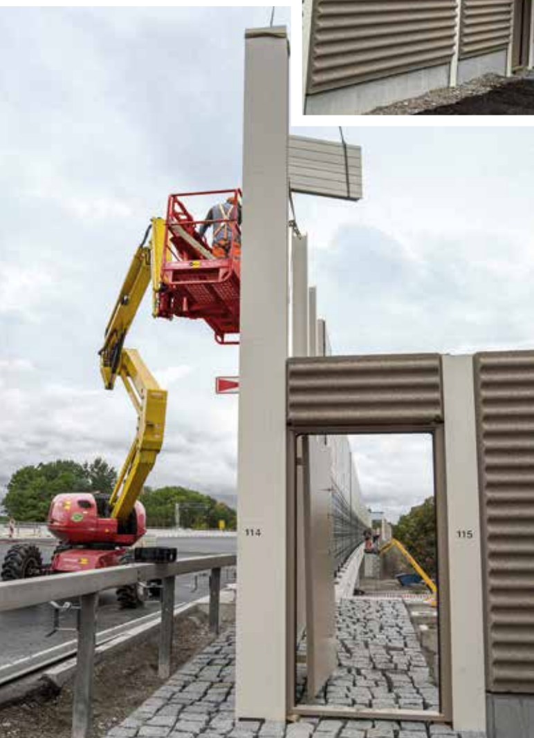
Fünf Gelenk-Teleskopbühnen von Zeppelin Rental unterstützten die Mitarbeiter des Bauunternehmens Josef Rädlinger unter anderem dabei, die schallschluckenden Concretelemente an Ort und Stelle zu setzen. Von beiden Seiten: Im Akkord wird an der Lärmschutzwand gearbeitet.
