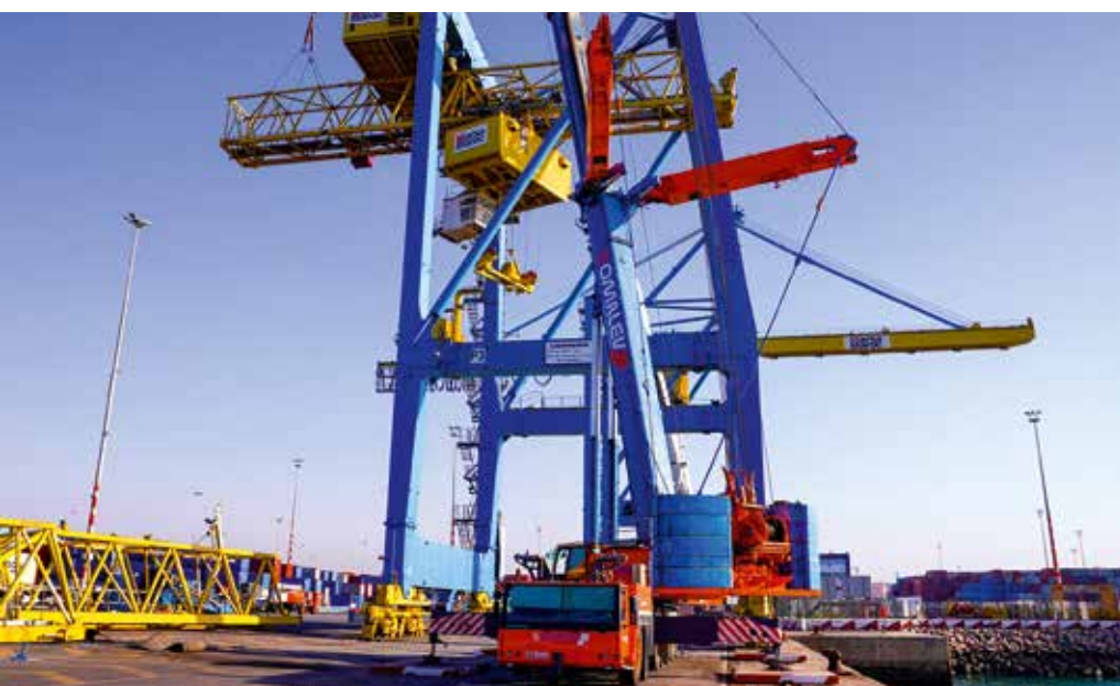
Die beiden Liebherr-Teleskopkrane arbeiteten eng abgestimmt zusammen, um die schweren Elemente des STS-Krans kontrolliert abzutragen.
