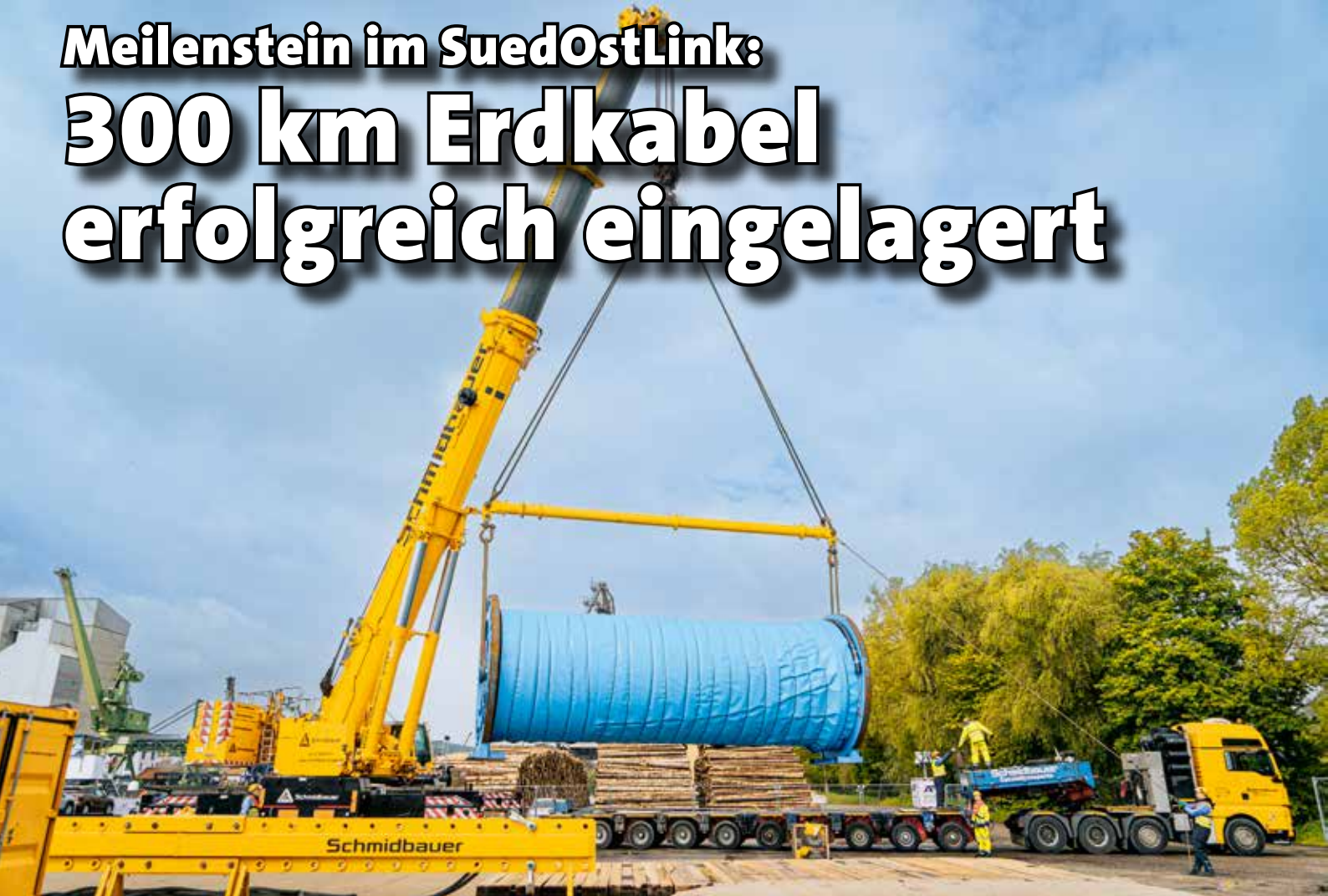
Eine Kabeltrommel von 10 Metern Länge, 4 Metern im Durchmesser, 1,75 km Kabellänge wiegt 80 Tonnen.
