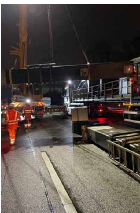
Der neue 4,5 Tonnen wiegende Querträger wird eingehoben.
