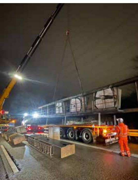
Ein alter Schilderbrückenträger wird ausgehoben.
