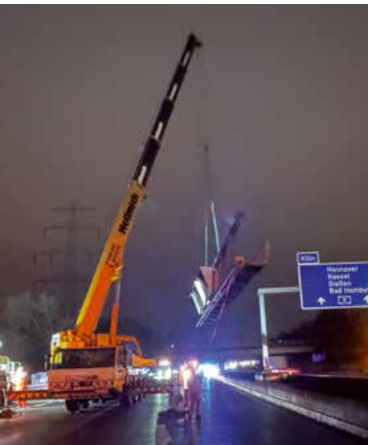
Nachts auf der A5: Hellmich Kranservice beim Aushub einer alten Schilderbrücke.
