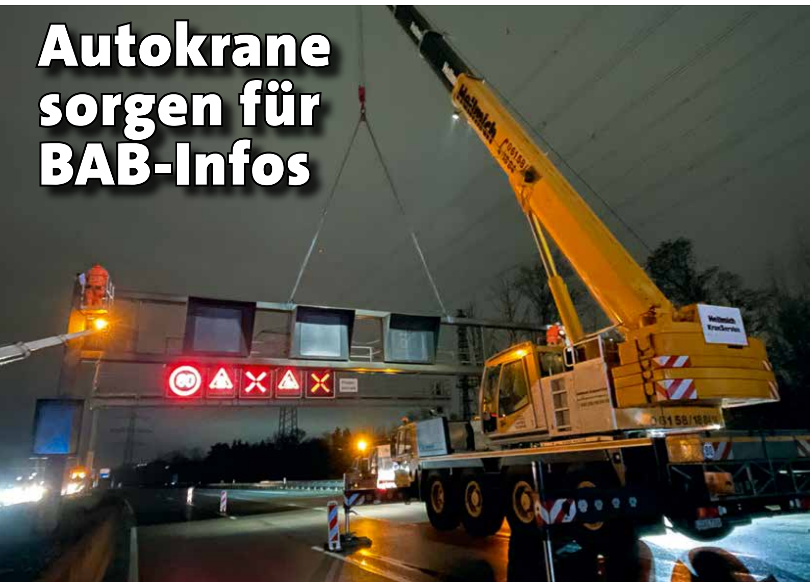
Die Demontage einer alten Schilderbrücke auf der A5.
