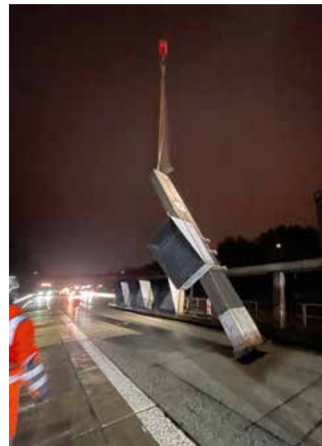
Eine neue Brückenstütze am Haken des ATF 70 von Hellmich.
