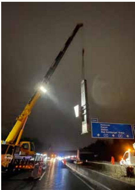
Eine der neuen 1,6 Tonnen wiegenden Stützen wird eingehoben.
