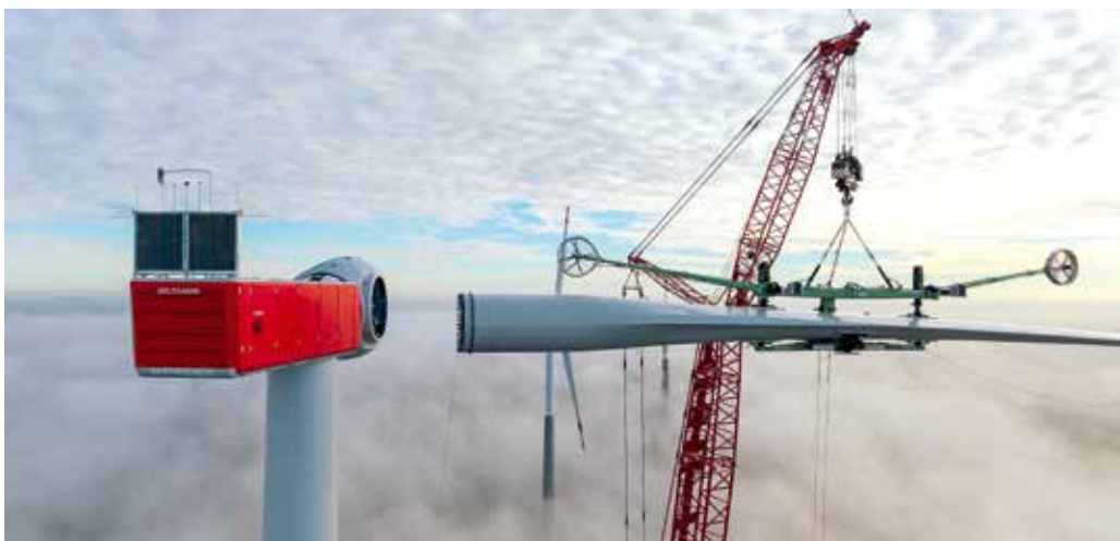
Zur Stabilisierung und Lageregelung der Blätter kam eine Traverse von Liftra sowie das Autonomous Positioning System von Seasight Solutions zum Einsatz. Durch die beiden Propeller kann die Lage des Blatts auch bei Wind bis zu 30 km/h kontrolliert werden.
