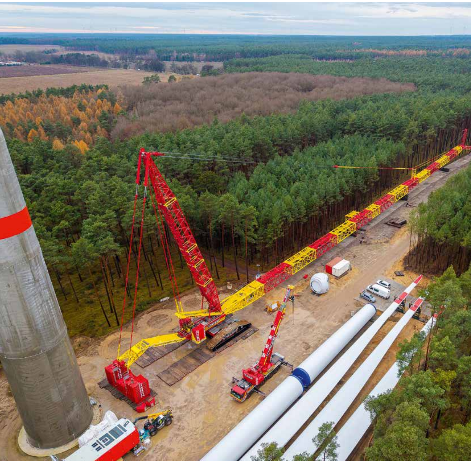
Drei 800-Tonner waren gleichzeitig im Windpark im Einsatz. Im Vordergrund der LR 1800-1.0 von Neeb, im Hintergrund kann man den Nolte LG 1800-1.0 erahnen. Der dritte im Bunde war ein LR 1800-1.0 von Hofmann.
