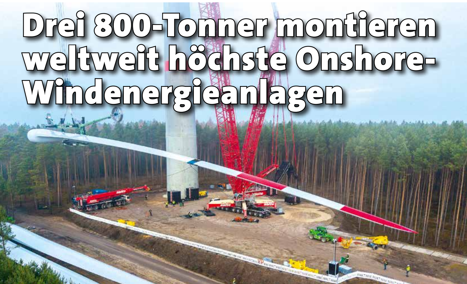
Nolte's LG 1800-1.0 beim Heben eines Rotorblatts der N175/6.X. Das Blatt ist 87,5 Meter lang und wiegt 30 Tonnen.
