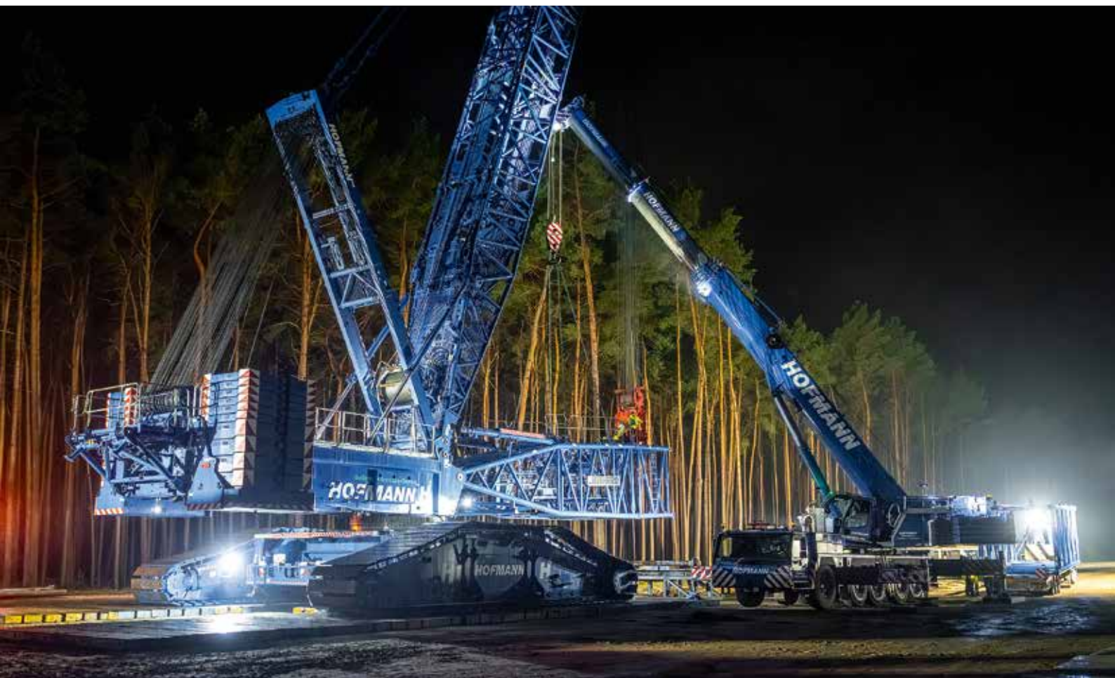
Nach dem Transport der Krankomponenten von der vorherigen Anlage wurde der LR 1800-1.0 von Hofmann nachts aufgebaut. Als Hilfskran kam ein LTM 1250-5.1 zum Einsatz.
