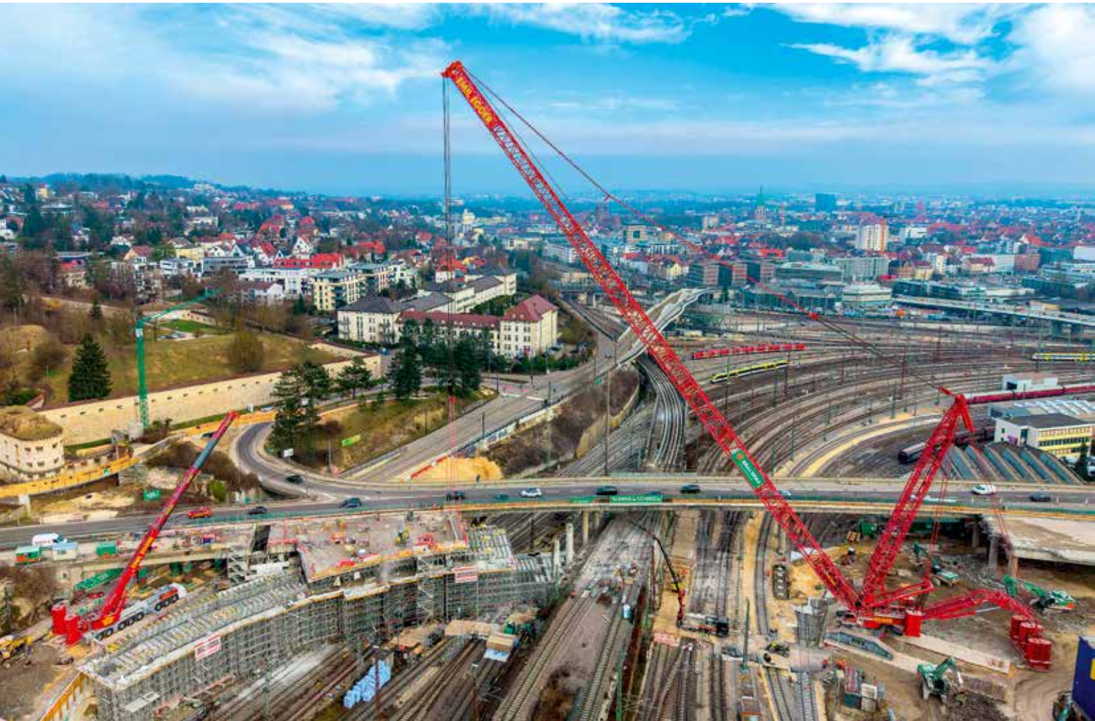
Um auch die weiter entfernten Segmente zu erreichen, wurde der Hauptausleger des Liebherr LR 11000 von 84 auf 126 Meter verlängert. Links im Bild der Mobilkran LTM 1650-8.1, ...
