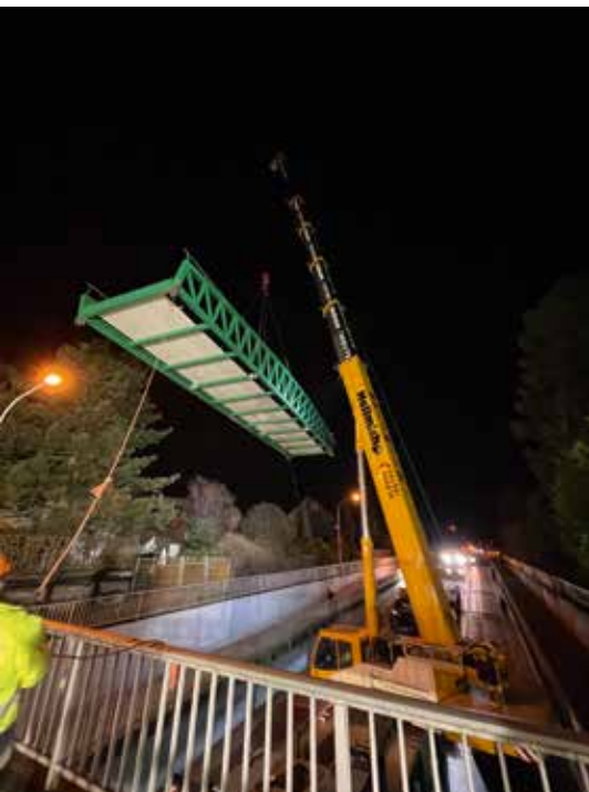
Die 4 m breite und 18 Tonnen schwere Brücke wurde mit einem Tadano AC 5.220-1 eingehoben.
