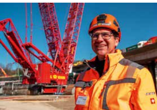
... sagt Geschäftsführer Michael Egger, der zum Auftakt der Arbeiten in Ulm selbst vor Ort war.
