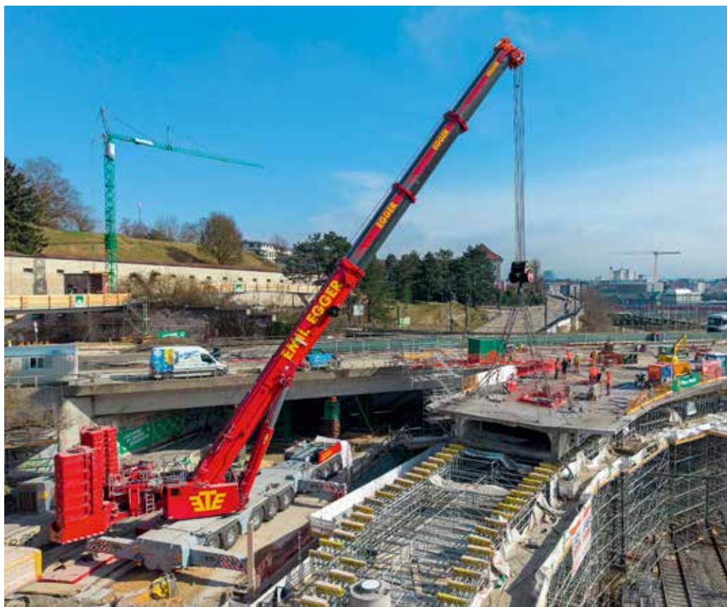
... der zeitgleich für den Rückbau einer Auffahrt zur Brücke zuständig war.
