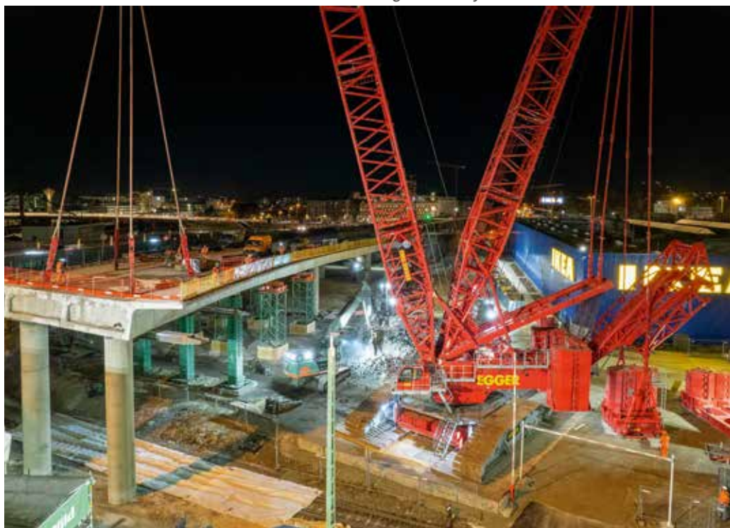
Im Schichtbetrieb wurde das Brückenbauwerk Stück für Stück abgetragen. Tag und Nacht waren Kran, Betonsägen und Bagger im Dauereinsatz.
