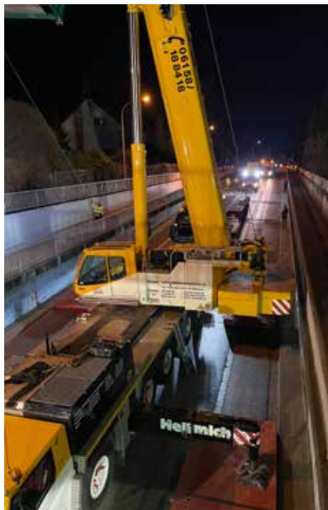
Die 4 m breite und 18 Tonnen schwere Brücke wurde mit einem Tadano AC 5.220-1 eingehoben.
