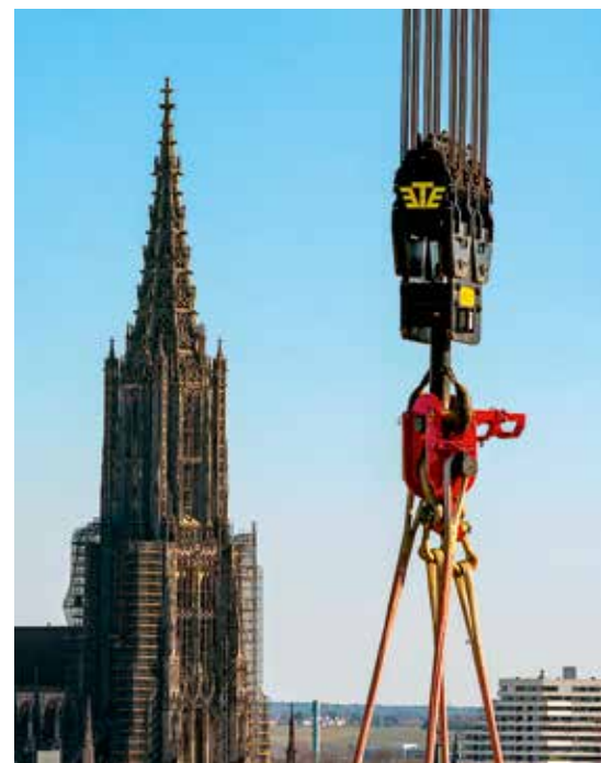
Ein Ausgleichsmechanismus an der Hakenflasche des Raupenkrans sorgte für die gleichmäßige Belastung aller vier Dyneema-Seile.
