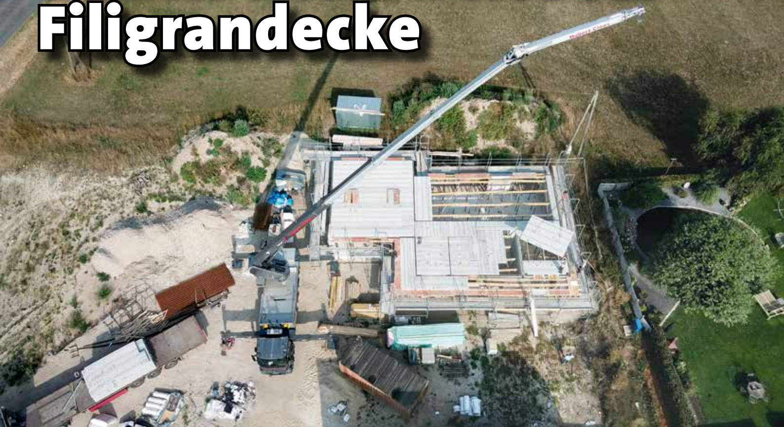
Böcker AK52 bei der Zwischendecken-Montage bei einem Wohnhaus in Goch.
