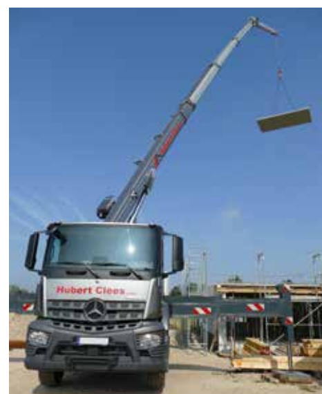
Ein Modul der Filigrandecke am Haken des Böcker AK52 vom Dachdeckerbetrieb Hubert Clees & Sohn GbR.
