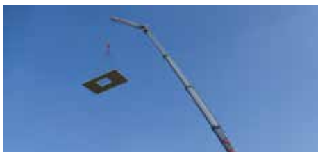
Ein Modul der Filigrandecke am Haken des Böcker AK52 vom Dachdeckerbetrieb Hubert Clees & Sohn GbR.
