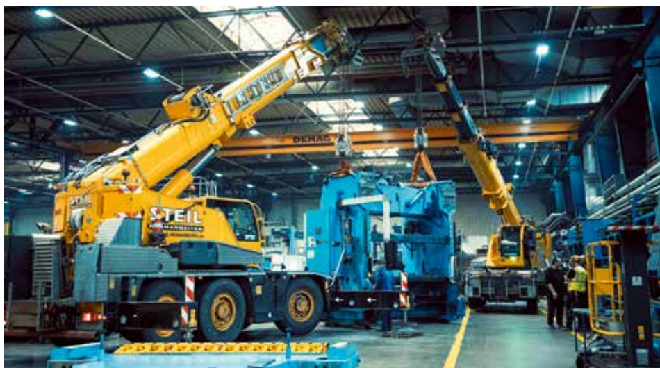
Im Tandem-Hub nehmen zwei City Krane die schwere Presse an den Haken.
