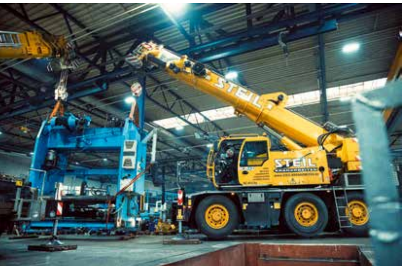
Zur Errichtung einer neuen Produktionslinie wurde eine Presse innerhalb der Werkshalle versetzt.
