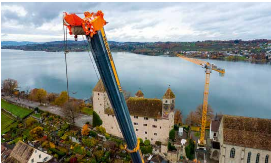
Clevere Lösung: Die Verwendung der Mastnase ersparte dem Feldmann-Team die aufwendigere Montage einer Gitterspitze.
