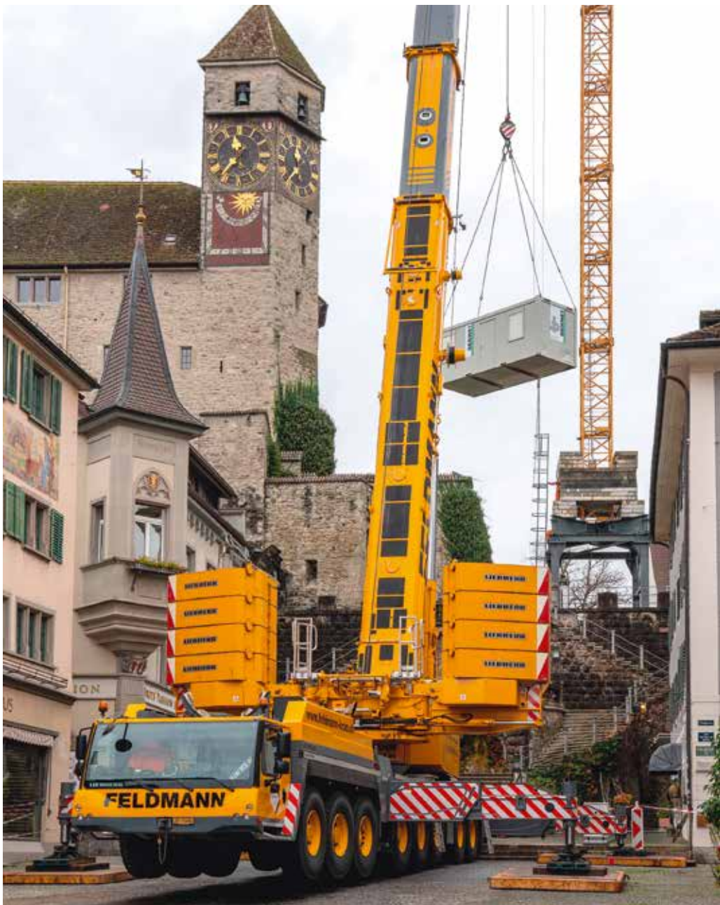
Standfest: Von der abschüssigen Straße der Altstadt aus erledigte der Liebherr-Kran alle Hubarbeiten ohne Probleme.
