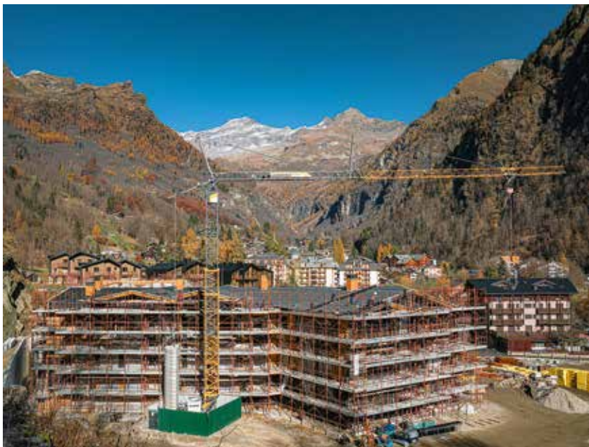
Der 81 K beim Bau der Mountain-Lodge in Piemont.
