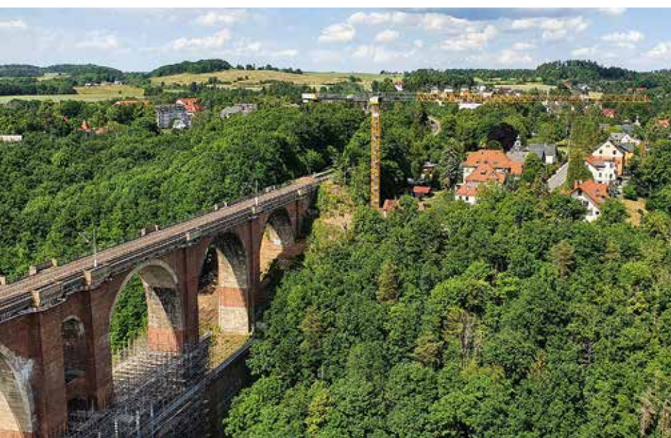
340 EC-B 16 mit Arbeitsbereichsbegrenzungen ausgerüstet, damit der Bahnbetrieb weitergehen kann.
