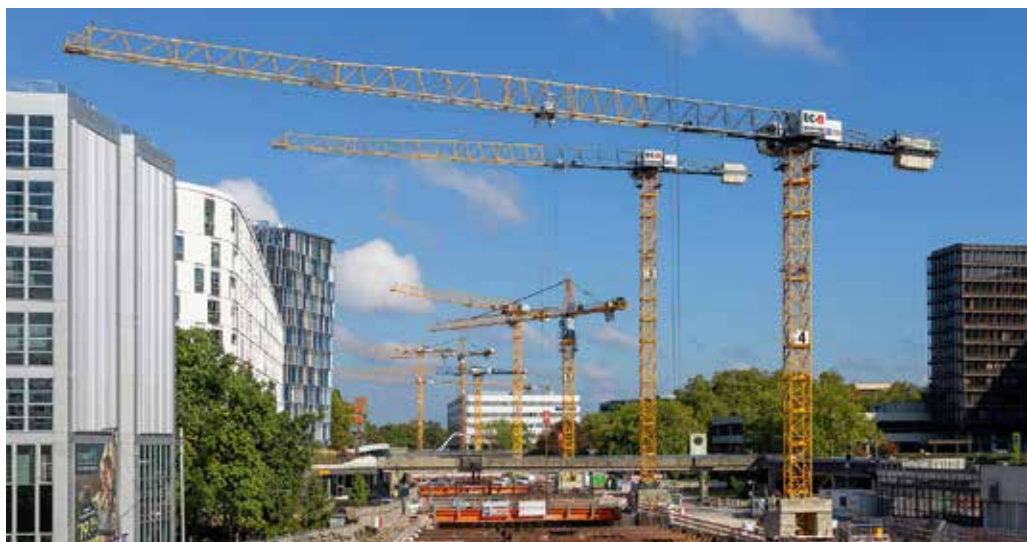
Die neue U-Bahn-Linie U5 wird künftig die östlichen und nordöstlichen Stadtteile Hamburgs an das bestehende Schnellbahnnetz anbinden.
