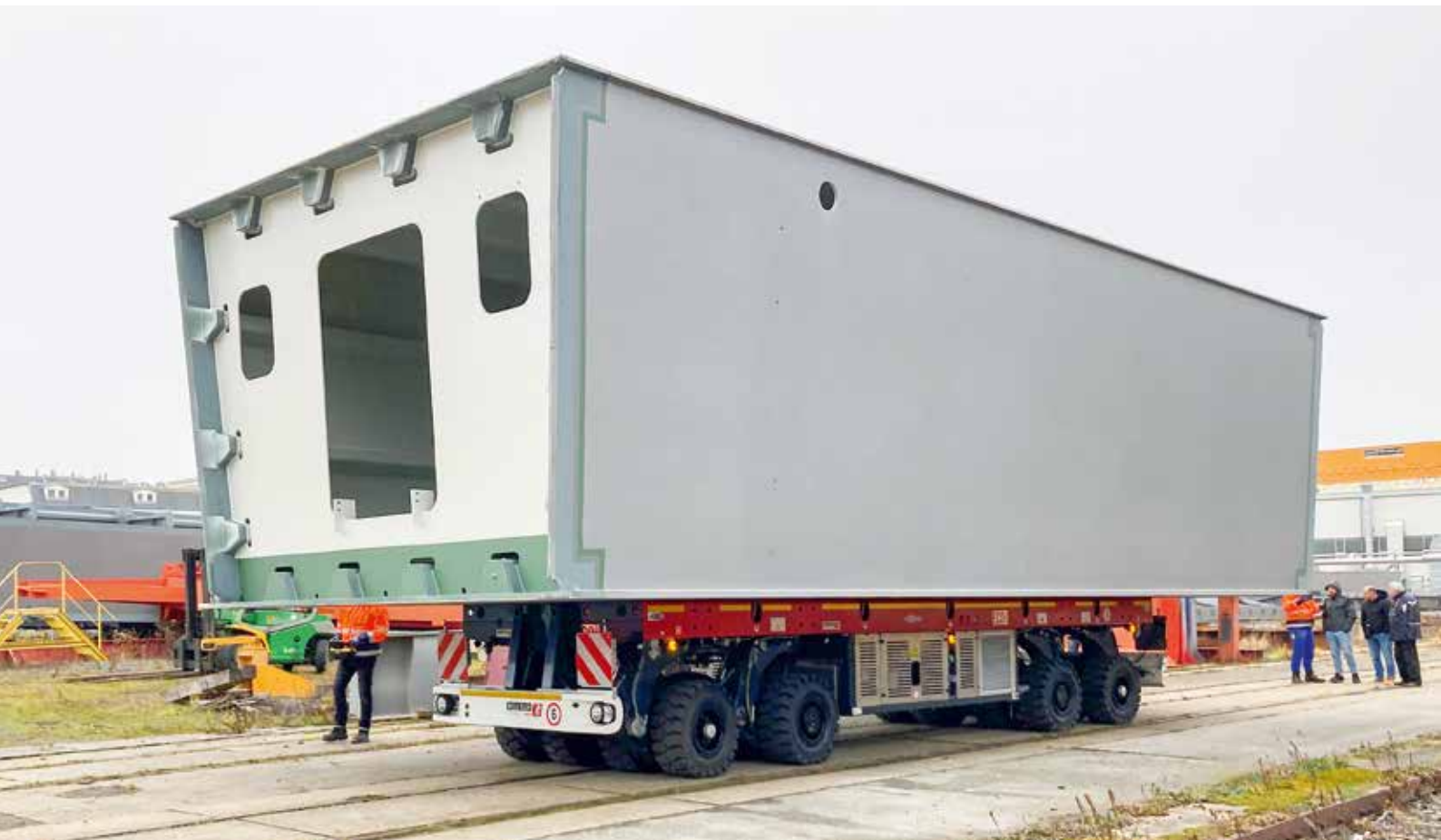
Direkt in den Einsatz: der Eco1000 übernimmt die angelieferte Brückensektion und ...
