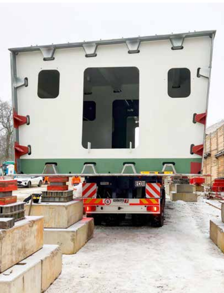
... platziert diese punktgenau auf den Elefantenfüßen.
